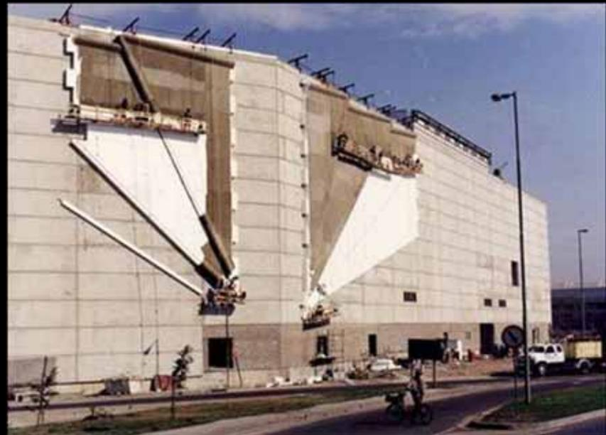
MURO COMPUESTO CON ESTRUCTURA INDEPENDIENTE, TERMINACION EXTERIOR DE LADRILLO VISTO CON AISLANTE TERMICO Y BARRERA DE VAPOR (AZOTADO HIDROFUGO Y EMULSION ASFALTICA), APLICADA SOBRE LA CARA EXTERNA DE LA HOJA INTERIOR DE LADRILLO CERAMICO HUECO DE 12, TERMINADO INTERIORMENTE, CON JAHARRO TRADICIONAL Y ENLUCIDO O REVOQUE MONOCOMPONENTE
